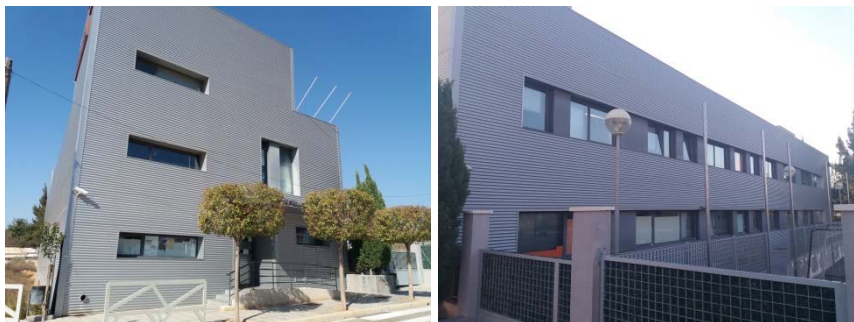
Imagen 2. Fachada de chapa grecada (tipo sándwich).
